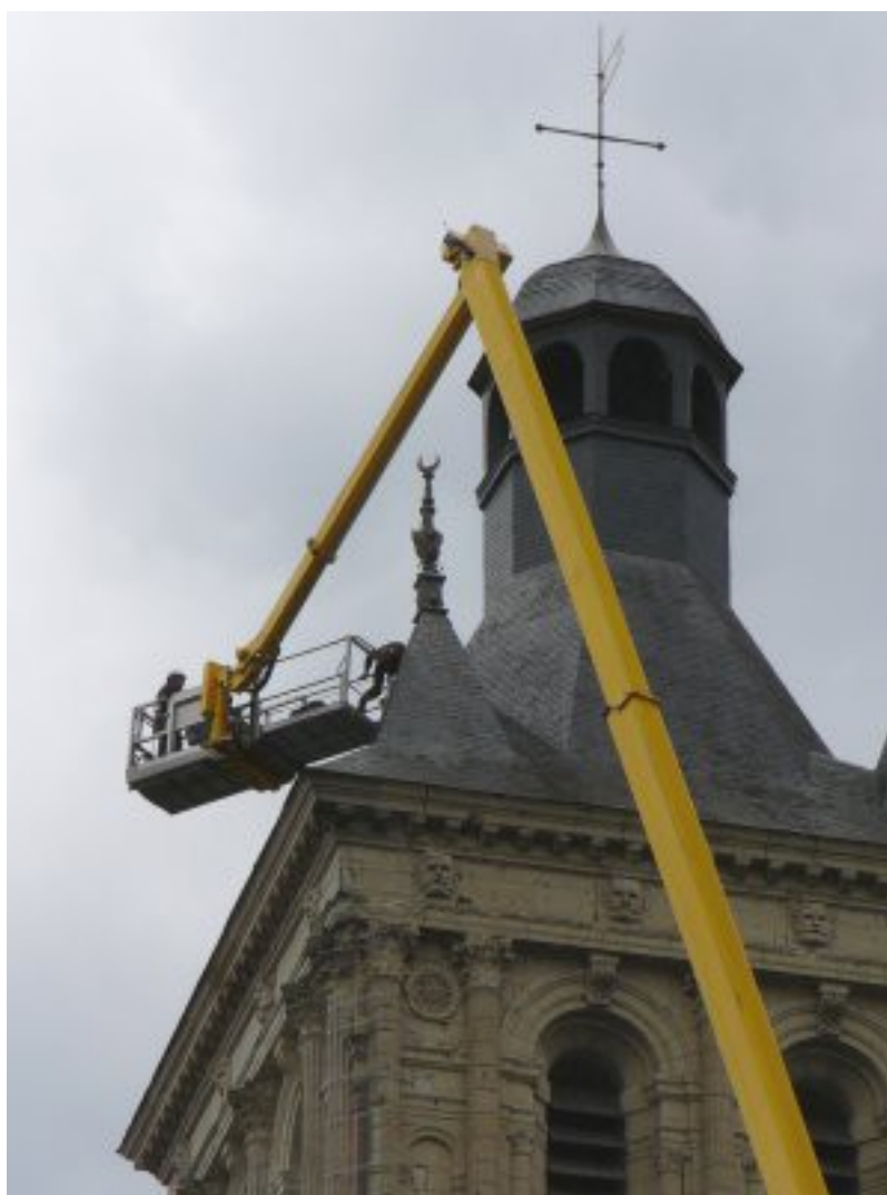
Les ouvriers en contrôle sur la nacelle
