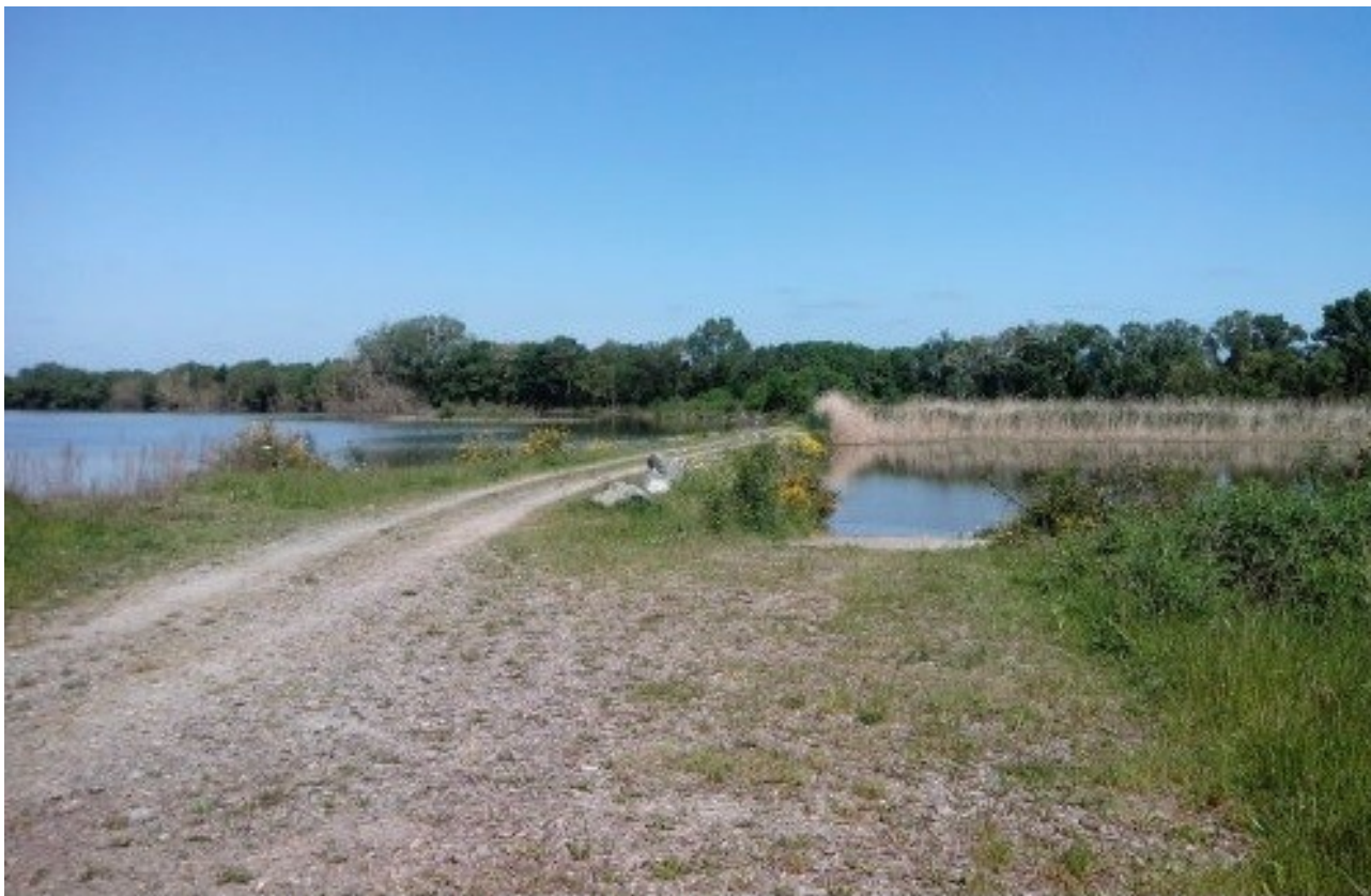
Fosse de Sorges à l'endroit de l'ancien bac de traversée de l'Authion
